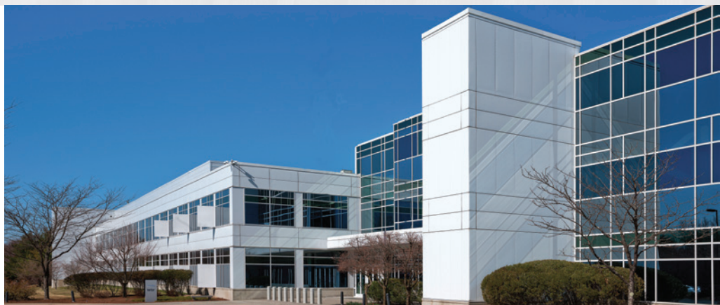
400 Minuteman Road, Andover は、アメリカのマサチューセッツ州にある2階建てのデータセンターです。
