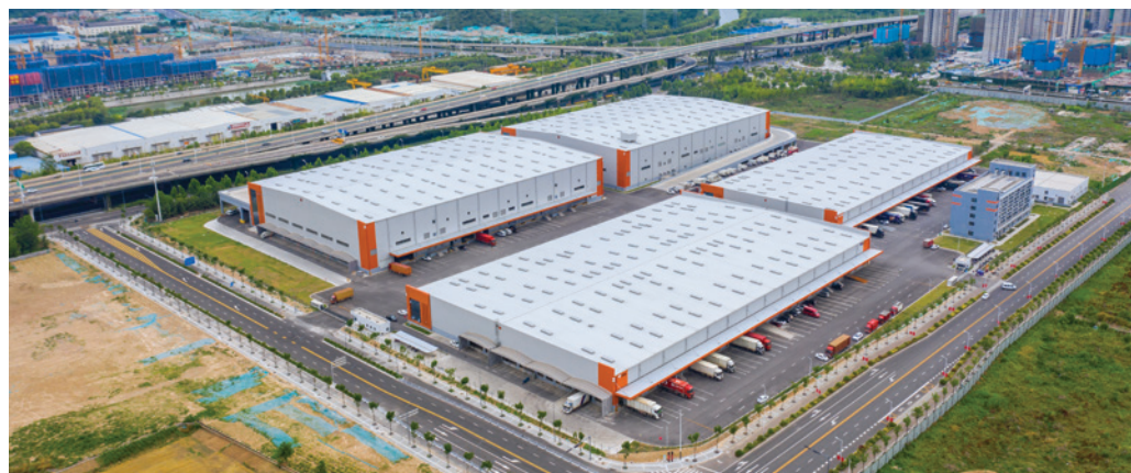
中国江蘇省の徐州市にあるMapletree (Huaihai) Supply-Chain Centerは、2棟の平屋倉庫と2棟の2階建てランプアップ倉庫から成り、賃貸可能面積は93,373m 2 。
