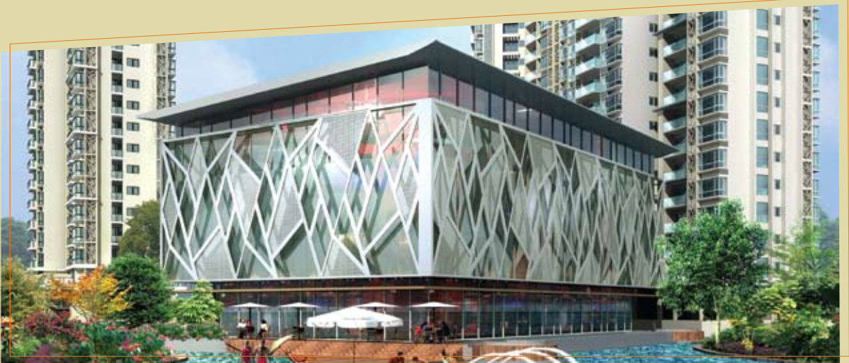
位于佛山的综合开发项目，南海商业城的第一阶段施工包括现代设施如商业中心。
