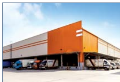
丰树常熟综合产业园
