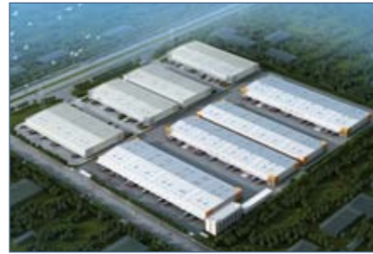
丰裕仓储(余姚)有限公司仓储物流项目
