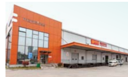
丰树长沙空港物流园
